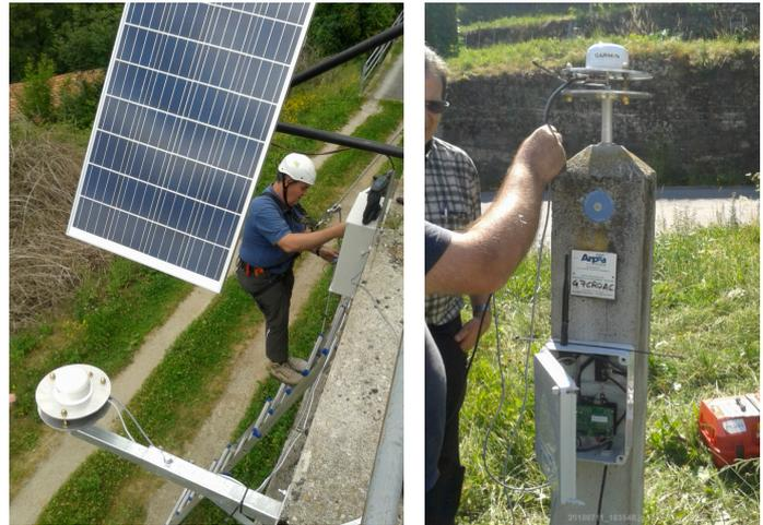
Figure 1: Componenti della centralina multi sensore e installazioni
