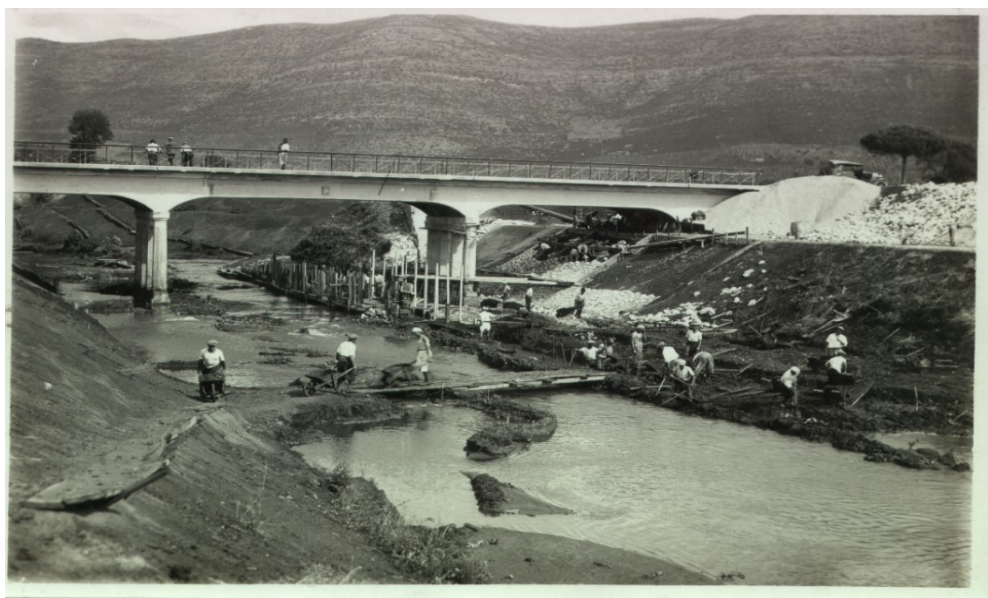
Figura 4 - Fiume Amaseno. Sistemazione dell'alveo a valle del ponte di Fossanova e costruzione del rivestimento – briglia sotto il ponte, 1932, CBP, Sottoserie Fotografie I, n. 482
