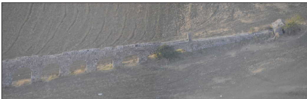
Figura 5 – Le strutture dell’acquedotto dovevano apparire maestose e suscitare rispetto verso il potere di Roma (foto D'Ascenzo, volo GREAL 2011).
